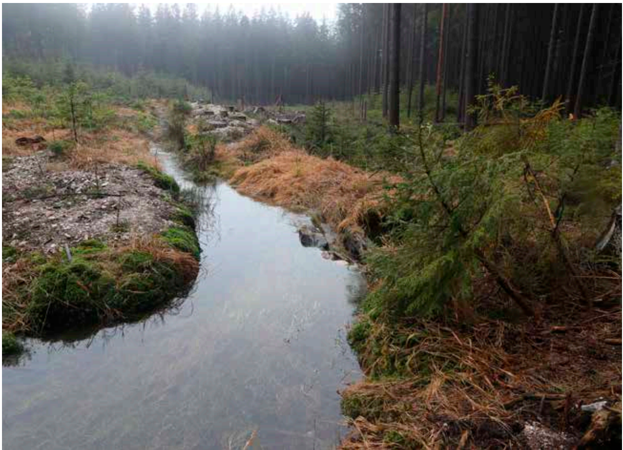
Obr. 2.03: Začátek Gangloffova náhonu; vpravo hrázka z kamenů, vlevo voda odtékající náhonem (foto Šimek 2019)
