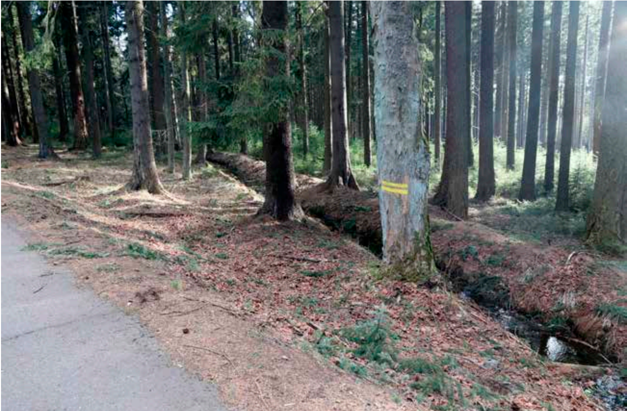
Obr. 2.05: Náhon u silnice Buková–Padrtě (foto Šimek 2019)
